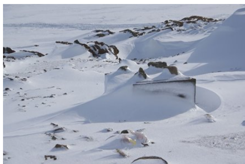
写真3 地磁気センサー庫にできたウィンドスクープとドリフト(風向きは右奥から左手前)
